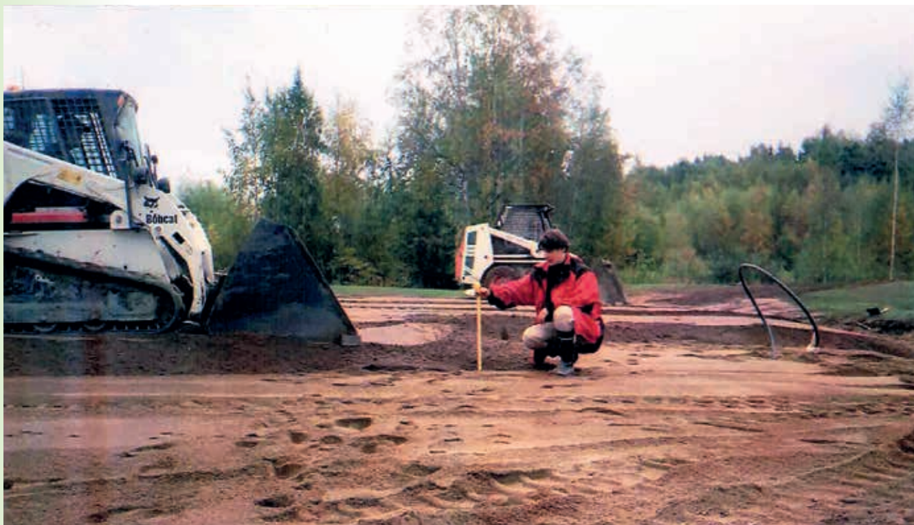
Riitta Pouttu mittaa salaojaputken asennuskorkeutta.
